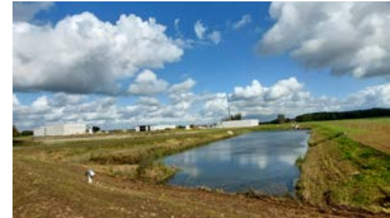
Recent aangelegde groenzone met 4 bufferbekkens
